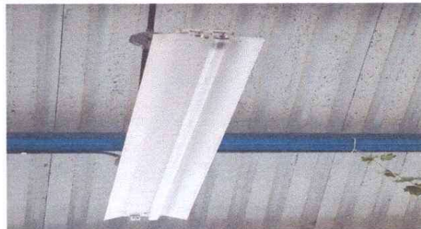
Foto 4: REPARACION DE SISTEMA ELECTRICO EN AULAS
