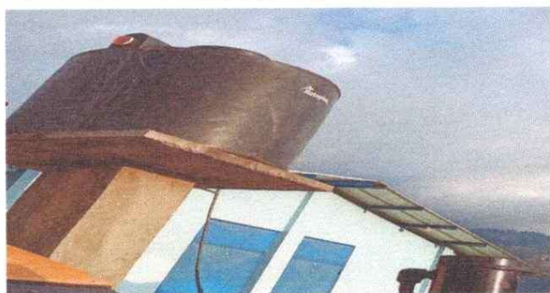
Foto 5: SUSTITUCION DE DEPOSITO DE AGUA
