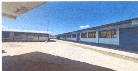
Foto 1: CANALES Y BAJADAS DE AGUA PLUVIAL
