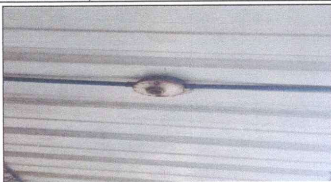
Foto 7: SUSTITUCIÓN DE PLAFONERAS
