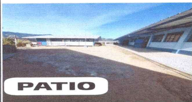
Foto 3: PLANCHA DE CONCRETO DE PATIO
